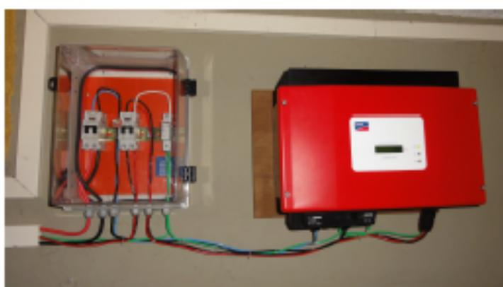
Figura 7 – Caixa de Junção e Inversor
