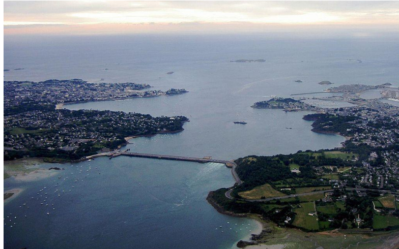
Figura 17 – Vista aérea da Usina Maremotriz de La Rance
